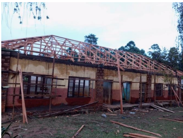
Durante i lavori
