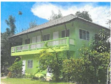
Ristrutturazione centro accoglienza
