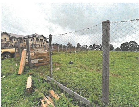
La recinzione che verrà sostituita
