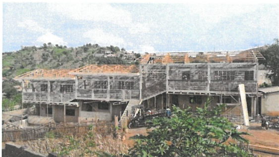
Rifacimento e completamento del tetto
